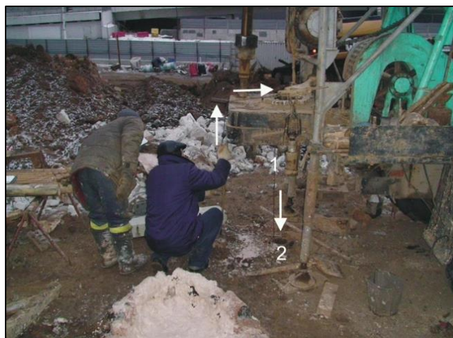
Рис. 3.12. Гамма-каротажное зондирование: 1-кабель, 2-створ скважины. Стрелками показано направление движения кабеля при опускании зонда
