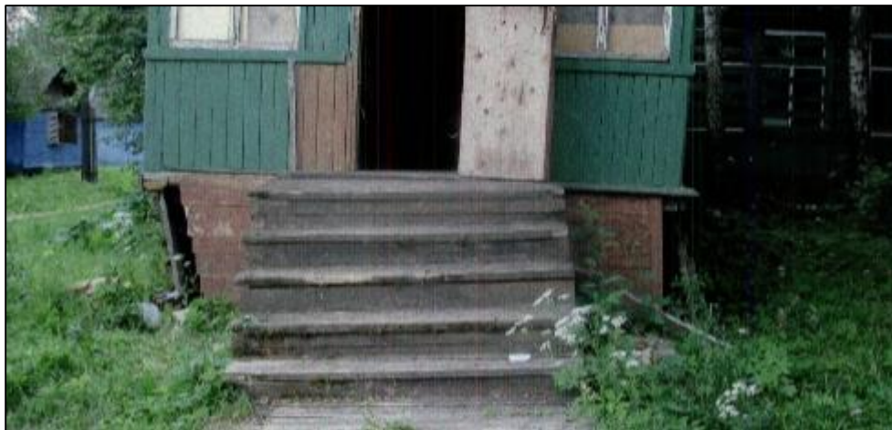
Рис. 1.39. Пример морозного пучения гляциальных суглинков и связанная с этим деформация здания
