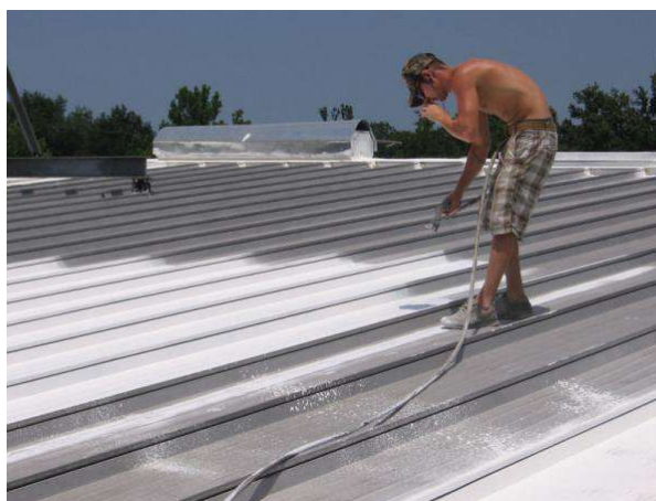
Рис. 2.9. Нанесение жидкой теплоизоляции
