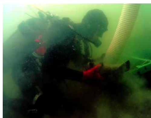
Рис. 3.16. Работа под водой
