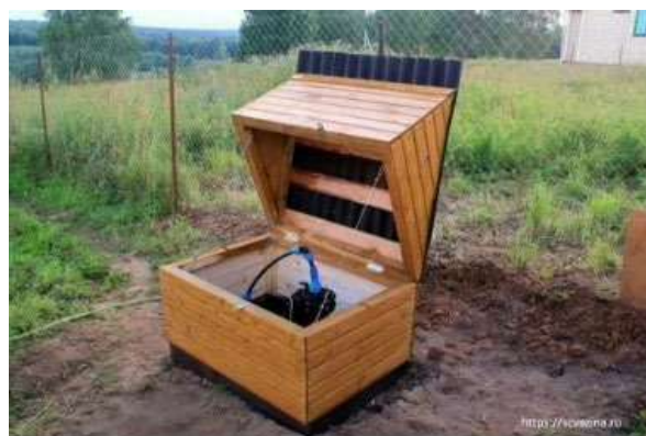
Рис. 11.25. Водозаборная скважина на дачном участке
