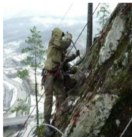
Рис. 9.18. Защита от камнепадов сетчатого типа
