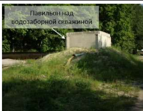
Рис. 11.29. Эксплуатационные водозаборные скважины
