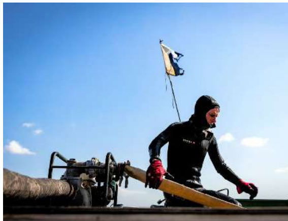
Рис. 3.17. В процессе подготовки грунтососа к работе
