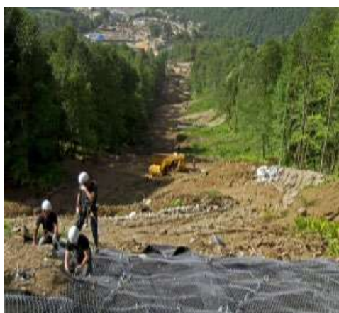
Рис. 9.17. Защита от камнепадов сетчатого типа
