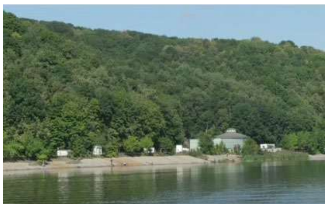
Рис. 11.27. Прибрежный водозабор подземных вод
