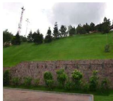
Рис. 9.12. Подпорная стена с облицовочным камнем
