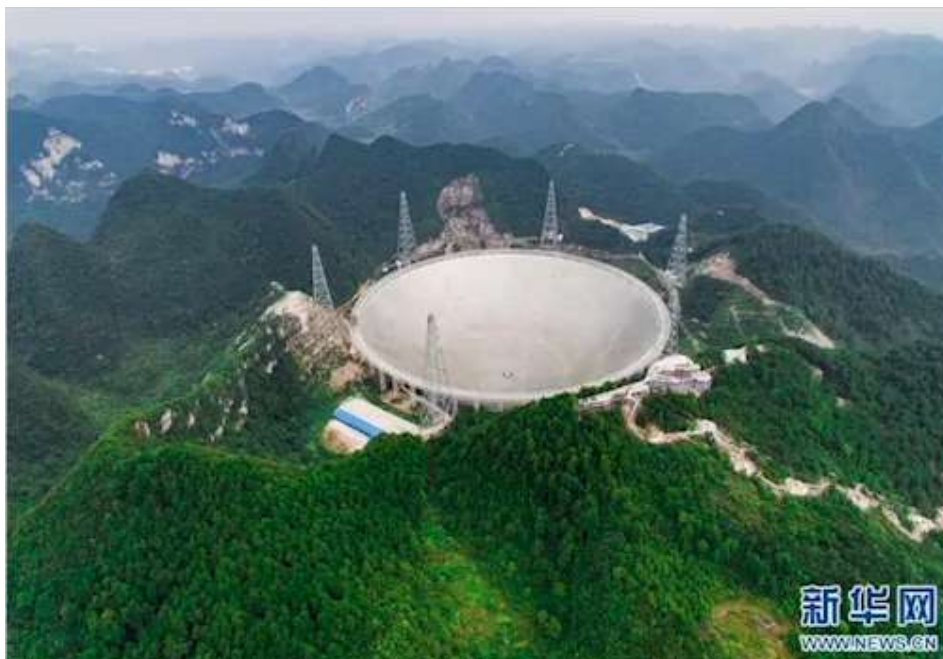
Рис. 6.6. Радиотелескоп в Китае. Диаметр главного рефлектора 500 м
