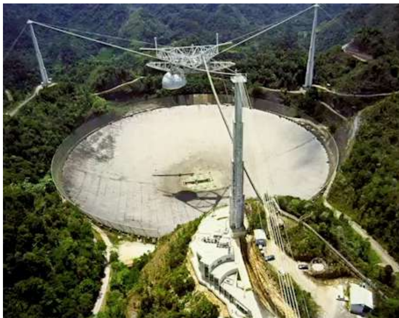
Рис. 6.6. Радиотелескоп в Аресибо, о. Пуэрто-Рико. Диаметр главного рефлектора 305 м
