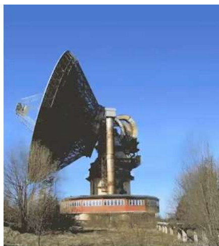
Рис. 6.5. Радиотелескоп. Антенна диаметром 64 м Калязинской радиоастрономической обсерватории
