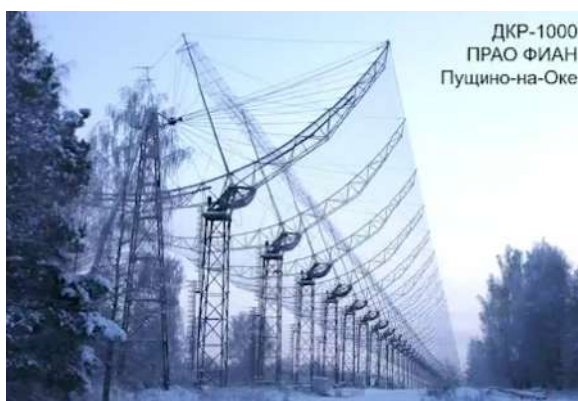
Рис. 6.10. Диапазонный крестообразный радиотелескоп 1000 м
