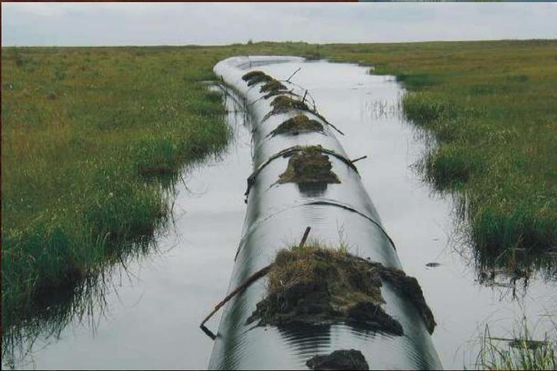
Деформации магистральных трубопроводов диаметром 1420 мм вследствие оттаивания и потери несущей способности грунтов основания на участке КС Ямбургская – КС Ныдинская.
